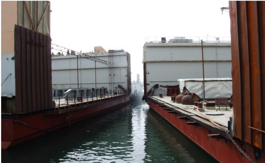
Рис. 1 – Стыковка блоков на плаву (окончание)
