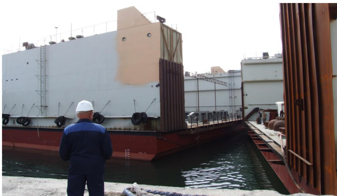
Рис. 1– Стыковка блоков на плаву (начало)
